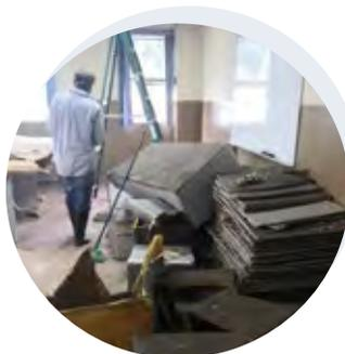
*Realizando el reemplazo del cielo raso de los laboratorios de informática de la Facultad*
