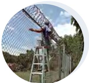
*Aplicación de pintura anticorrosiva a la cerca perimetral de ciclón*
